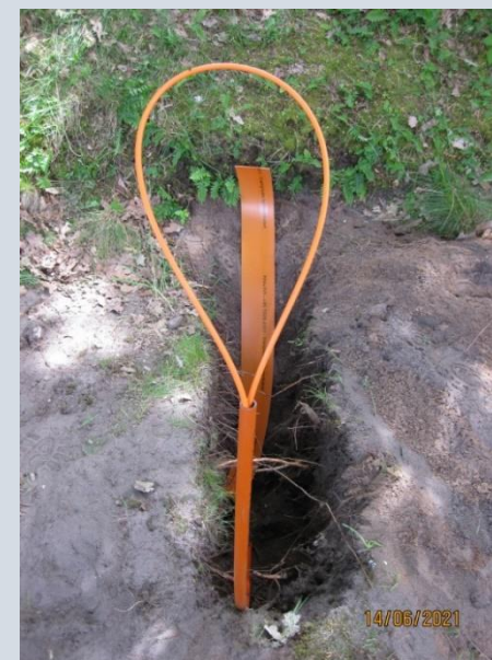
Kabelrørs ende mod vej
