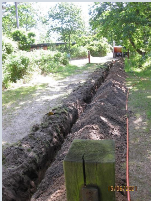
Kabelrøret parat til nedlægning i renden
