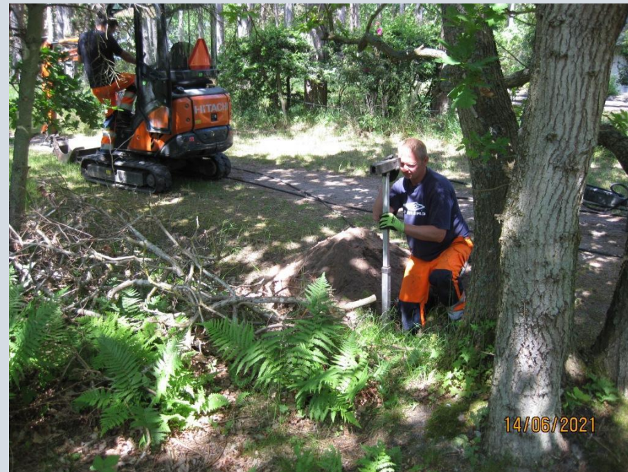
Pejling af retningen for indskydning af fiberkabelrør ved R 17
