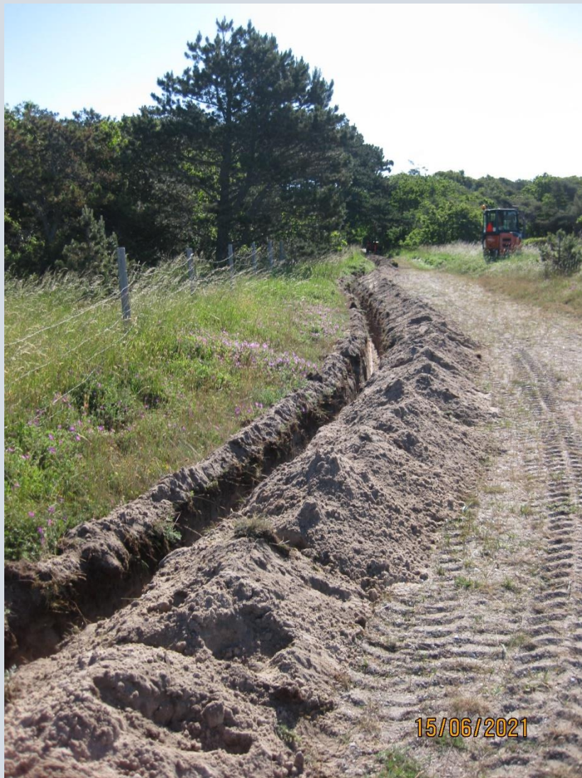
Opgravning langs familien Bech's hegn. Fibias oprindelige plan viste en kabelføring til Bech's hus nedad Bech's egen vej, men ved at føre kablet nedden om stranden har Fibia sparet næsten 500 meter opgravning og har samtidig undgået at genere skovens træer – godt tænkt !
