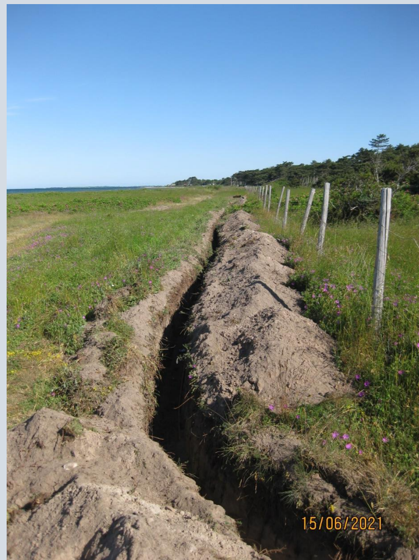
Opgravning langs familien Bech's hegn. Fibias oprindelige plan viste en kabelføring til Bech's hus nedad Bech's egen vej, men ved at føre kablet nedden om stranden har Fibia sparet næsten 500 meter opgravning og har samtidig undgået at genere skovens træer – godt tænkt !
