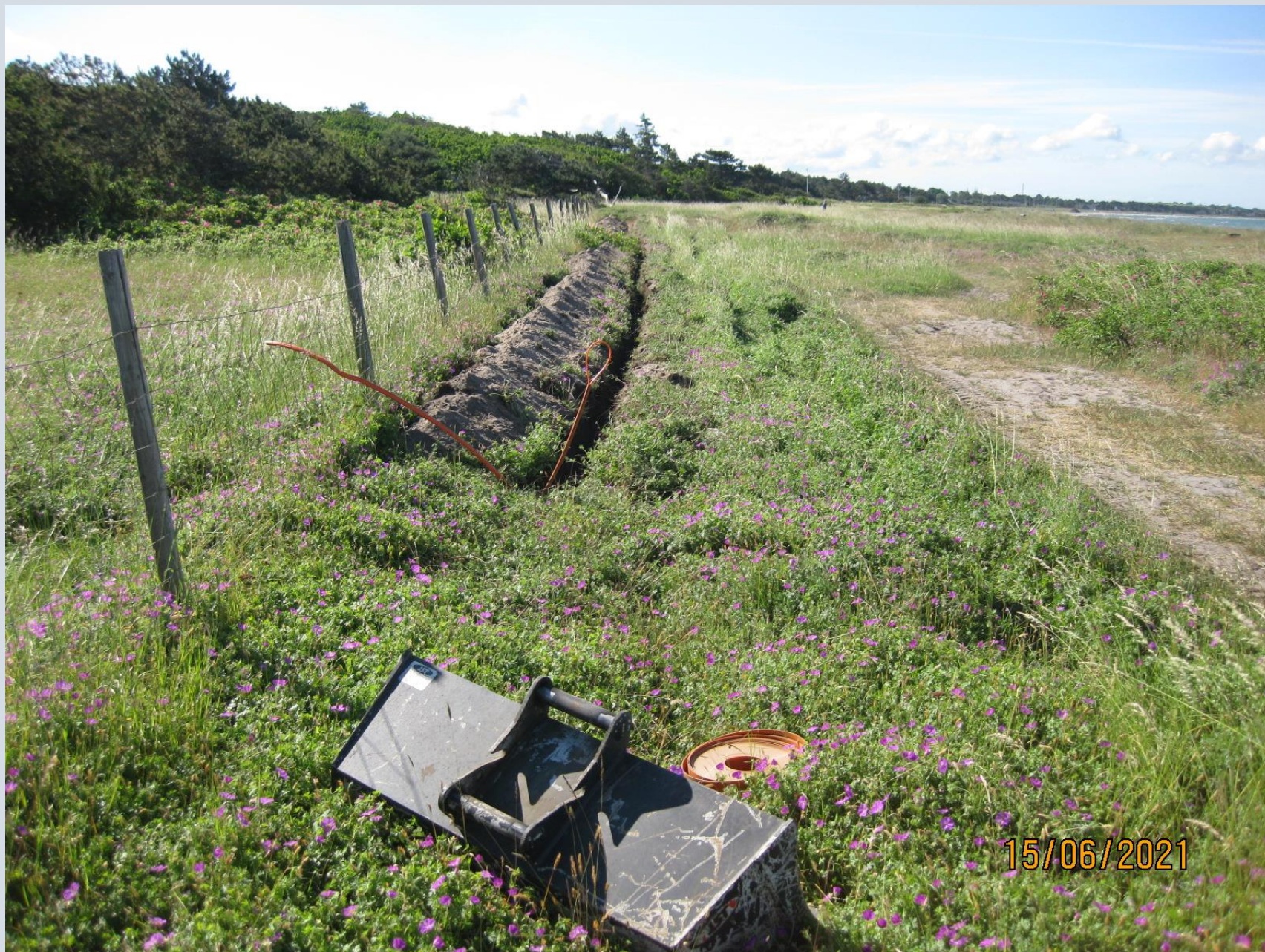
Kabelføring foran Bech's hus. Herfra skydes kablet under jorden og hen til husets fundament.
