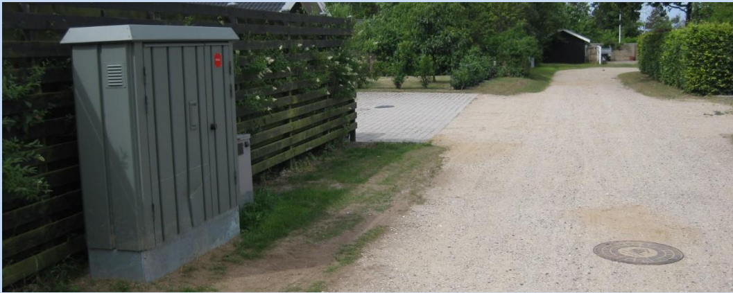
Bregnevej - dæksel pumpestation \varnothing 70 cm midt på vejen. Skelbrønd dæksel \varnothing 50cm (anes centralt i baggrunden)
