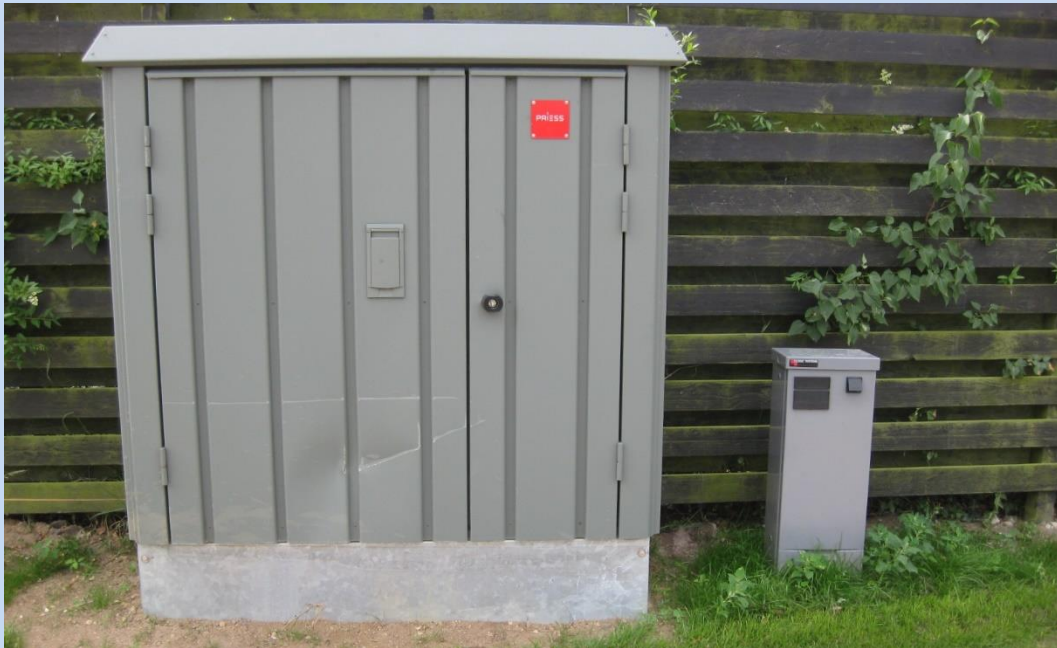
Bregnevej - til venstre teknikskab til pumpestation: h 155cm x b 170cm x d 52cm til højre Strømskab SEAS-NVE: h 75cm x b 34cm x d 21cm
